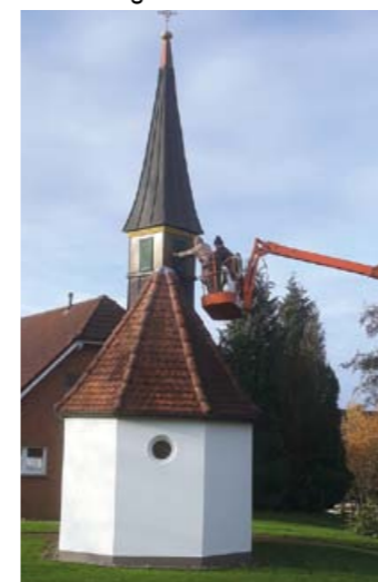
Mit dem Hubsteiger konnten Markus Schniederbernd und Lutz Simon die Abdeckungen am Turm austauschen.
