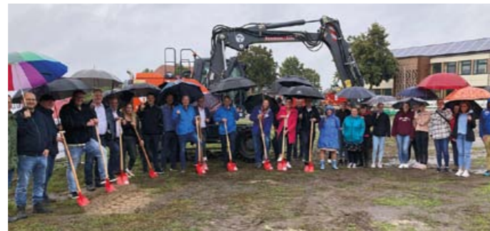
Beim gemeinsamen Spatenstich packten alle Beteiligten mit an und freuen sich auf den Start der Bauarbeiten für die neue Kindertagesstätte.
